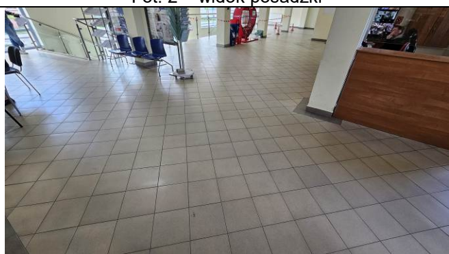
fot. nr 4 – widok posadzki
