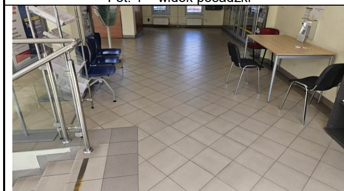
fot. nr 3 – widok posadzki
