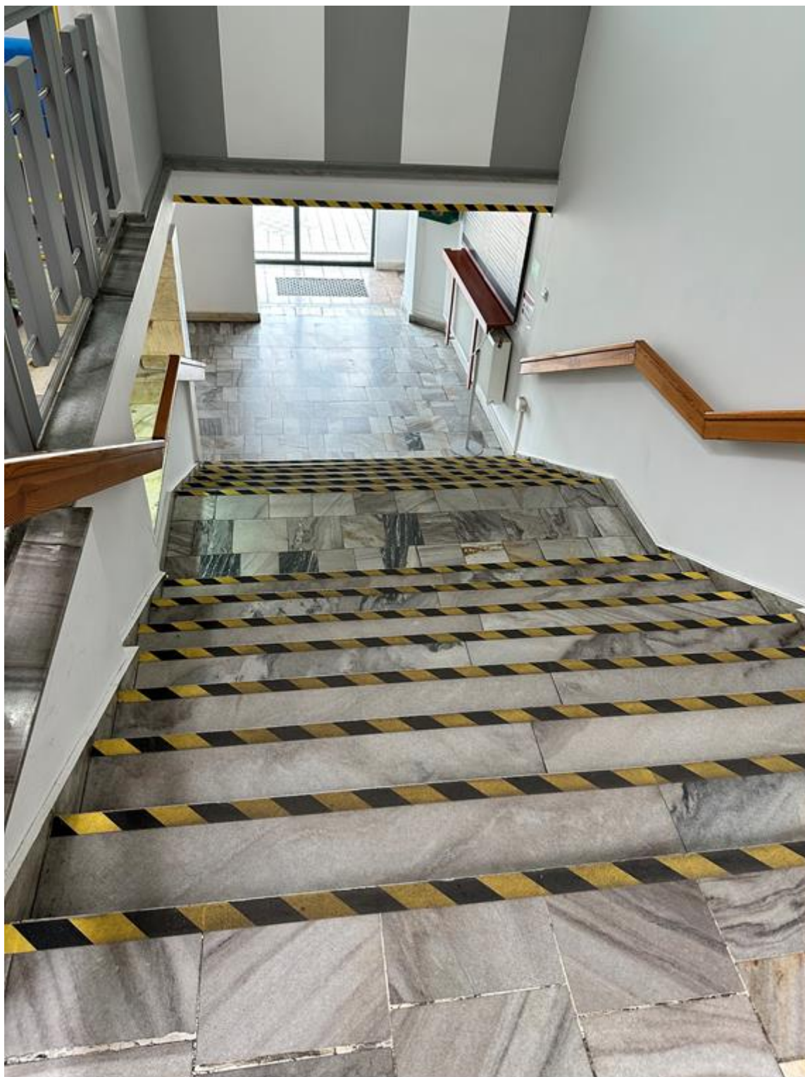
Rysunek 2 Zdjęcie istniejącej klatki schodowej
