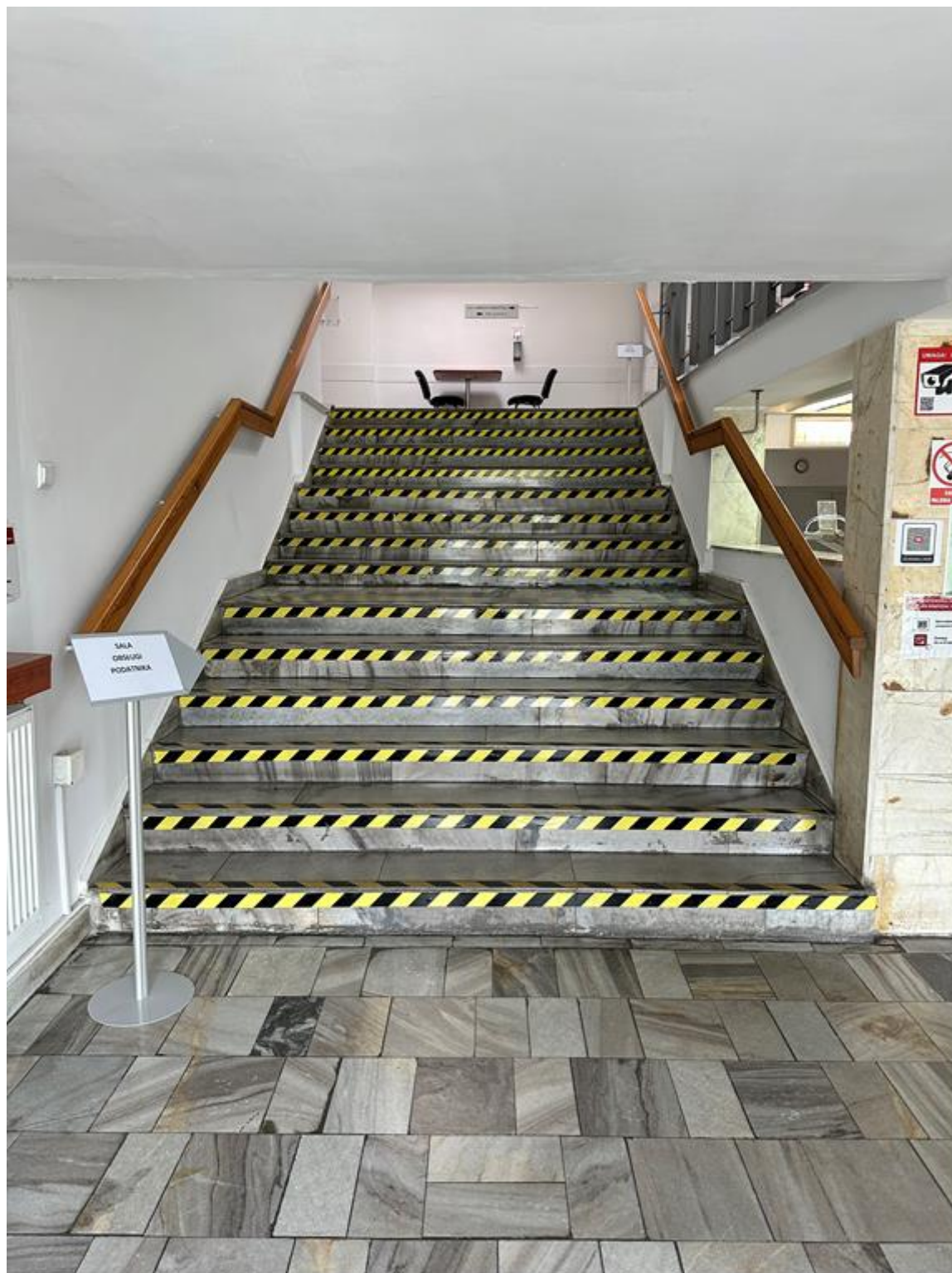
Rysunek 3 Zdjęcie istniejącej klatki schodowej
