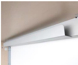
rys. 8- kanał kablowy z rynną kablową
